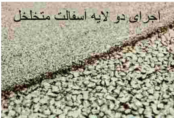
شکل شماره ۵ - اجرای دو لایه آسفالت متخلخل
